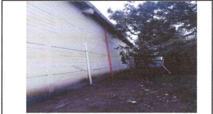
Foto 4: Sustitución de bajada de agua pluvial por tubo PVC de 3 pulgadas
